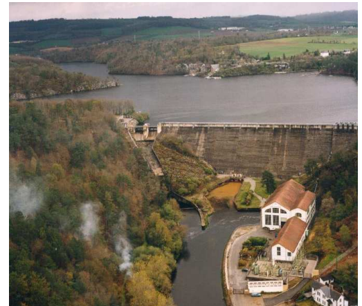
Crédits : Barrage de Guerlédan (22), EDF
