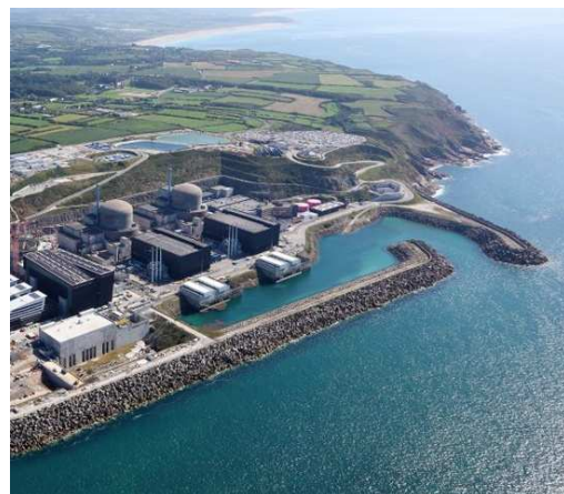
Crédits : Centrale de Flamanville (50), EDF
